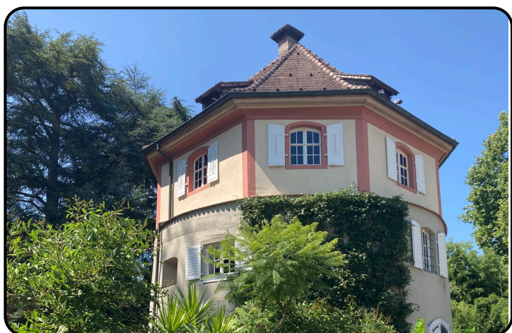
La Gärtnersturm construite au XIXème siècle sur les ruines d'une ancienne fortification.
